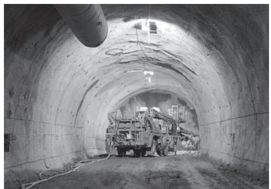
工事用トンネル掘削状況 (JR東海HPより)
